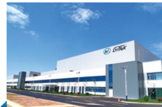
▲ 德州基地——山东有研半导体材料有限公司 (2020年启用)
